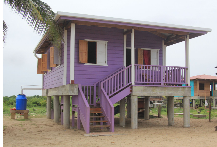
Viviendas resilientes en la comunidad de Haulover, Costa Caribe de Nicaragua
